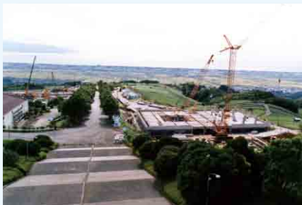
【建設中の4号館／1990(平成2)年9月】 翌年春の開発工学部開設を控え、急ピ ッチで4号館の建設が進む(右手前)
