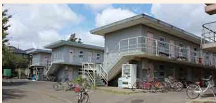
課外活動の各クラブの部室が連なって入居しています。「部室第1棟」(総合体育館西)が1967(昭和42)年3月、「第2棟」(ラグビー場西)が同年10月に竣工。以後1995(平成7)年5月竣工の「第9棟」(テニスコート西)まで順次建てられました。第5棟は欠けており、全部で8棟。写真は手前から第6、4、3の各棟です。いずれも構造はコンクリートブロック造2階建て。延床面積は445.04㎡(第1、第2棟とも)から124.92㎡(第3棟)まで、まちまちです。
